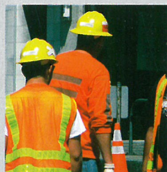
En la construcción
